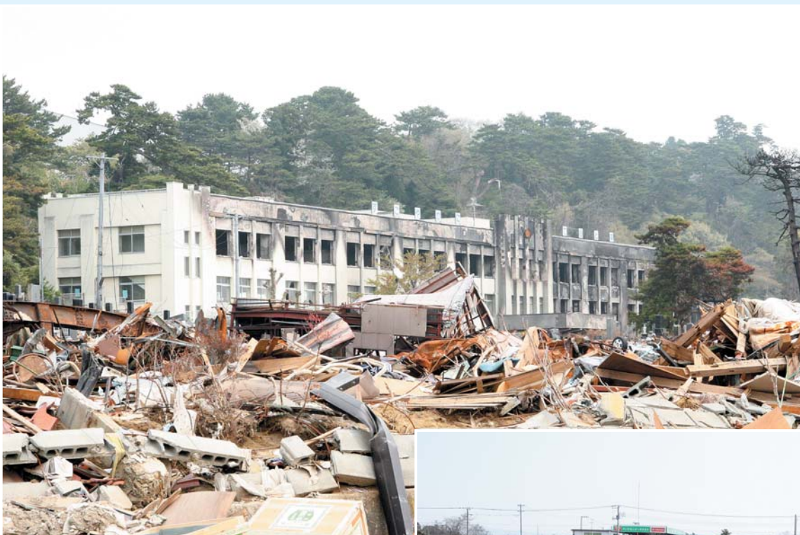
津波と火災で被災した石巻市門脇小学校
